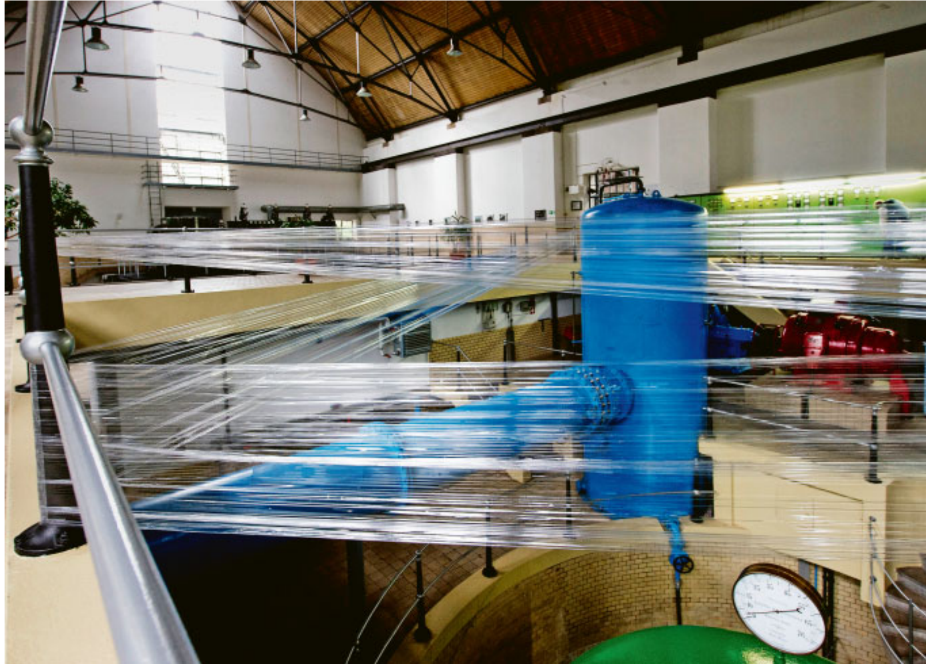
Klangkunst im Wasserwerk: Zu den Tagen der Industriekultur ist das Werk in Hattersheim geöffnet, eine Installation lässt die Geräusche der Anlage ertönen.
